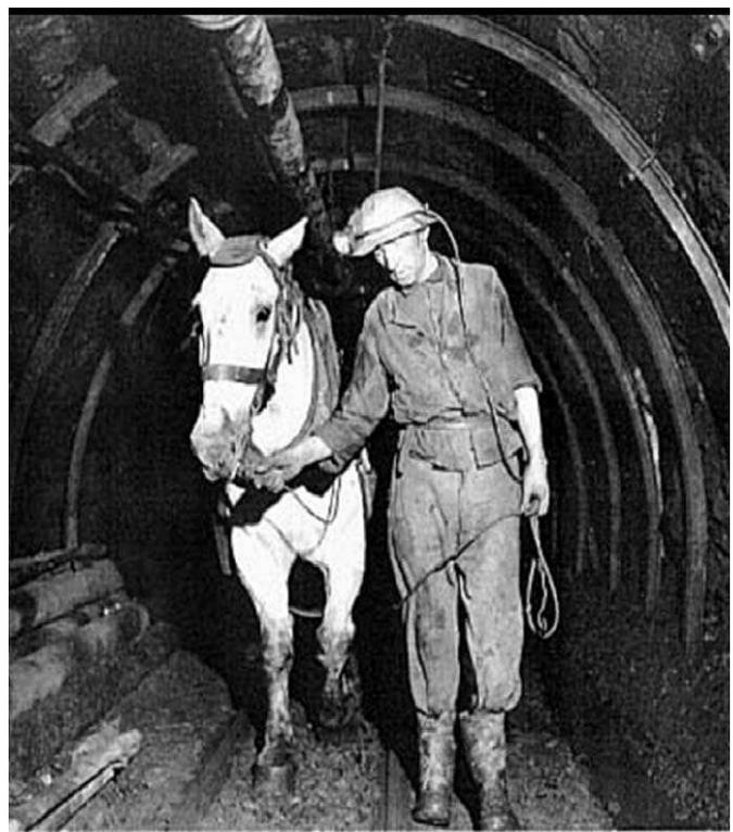
*Figure 32. Galerie boisée. Le soutènement de la galerie est en bois de sapin parce qu'il « parle », c'est-à-dire qu'il émet des bruits caractéristiques lorsqu'il craque et informe donc du danger en cours.*
