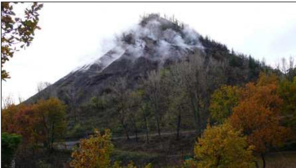
Figure 25. Le mont Ricarto, à Rochebelle, terril embrasé sur le bassin minier d'Alès (Gard), couvert de fumerolles (vapeur d'eau) par temps de pluie.
