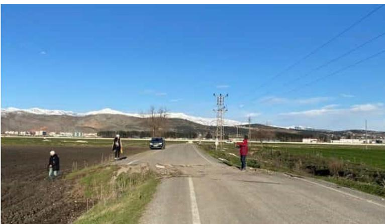
Photographie du décalage de la route (environ 3 m) suite au séisme principal et qui montre bien un décrochement senestre.
