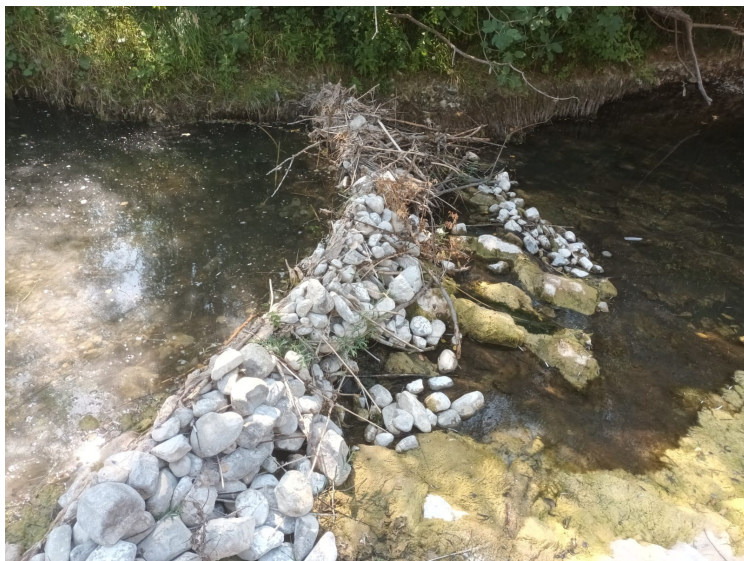
Fig. 10 : Barrage concave construit avec des pierres (photo Lionel COSTE).
