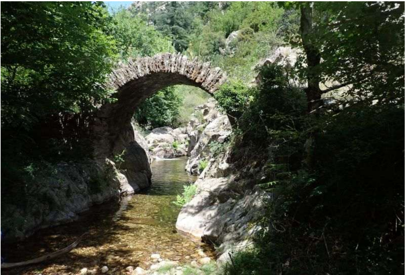
Le vieux pont de pierre dans le vallon du Cros [FA]
